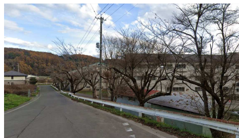
B: 敷地北側の町道から屋体方向を見る
