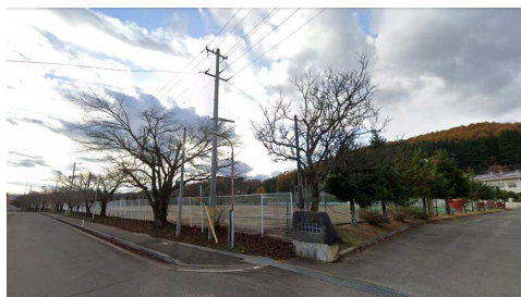
A: 正門からグラウンド方向を見る
