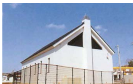
沼宮内中継ポンプ場
