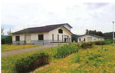
岩手町浄化センター
