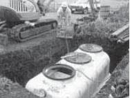
④掘った穴に浄化槽本体を設置する
