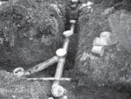
⑤浄化槽から家、水路までの配管を設置し接続する
